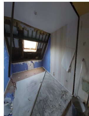
Sous les combles
