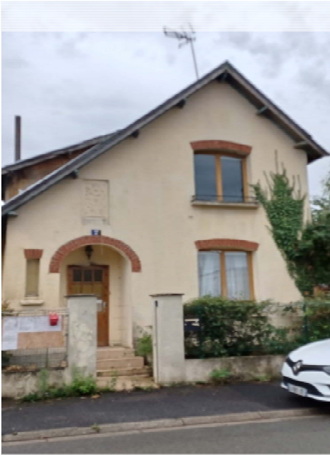
Devant le futur logement
